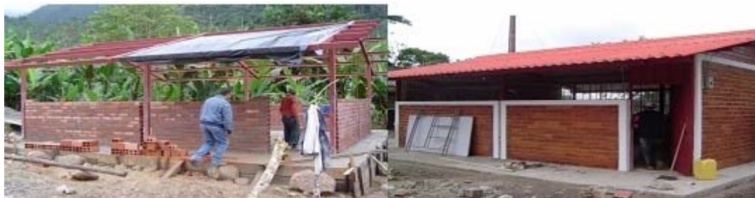
Fotografía No. 3 Avances de la construcción de las obras
