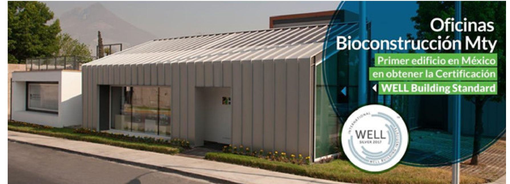
Ilustración 5. Oficinas Bioconstrucción Mty.
