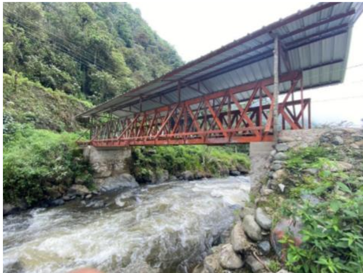
Figura 12.5: Estado actual del puente sobre el río Chaucha
