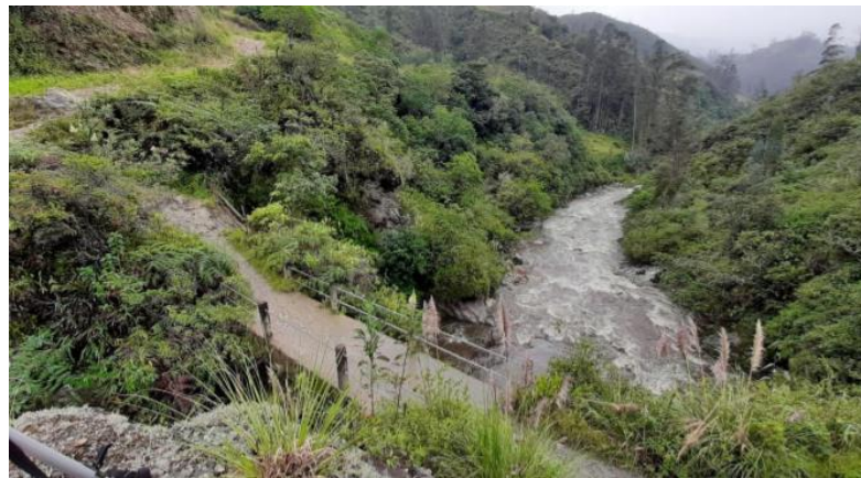
Figura 9.6 Estado actual del puente sobre el río Collay
