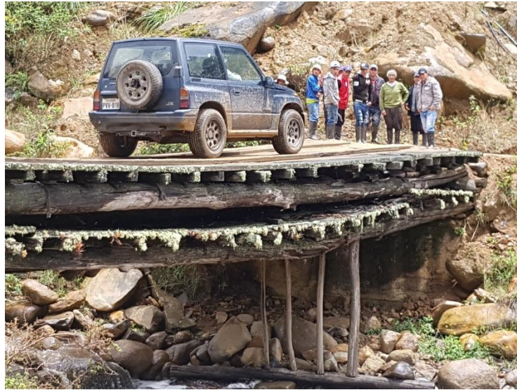
Figura 0.7: Estado actual del puente sobre el río Minas
