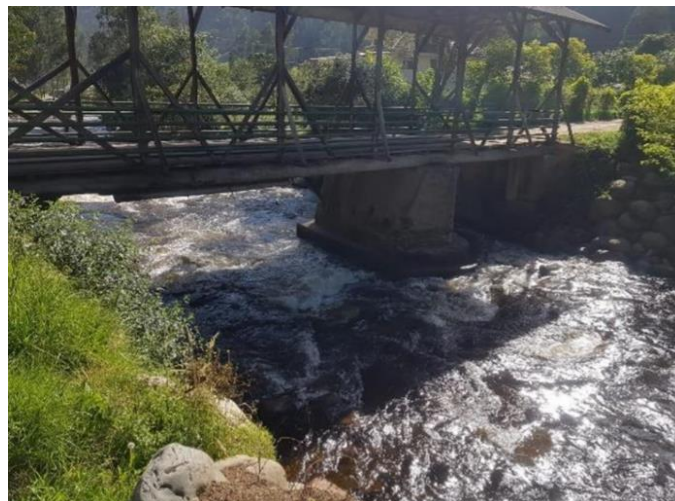
Figura 0.5: Estado actual del puente sobre el río Yanuncay
