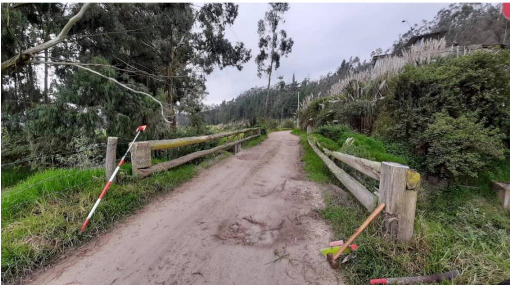
Figura 0.5: Estado actual del puente sobre el río Tarqui
