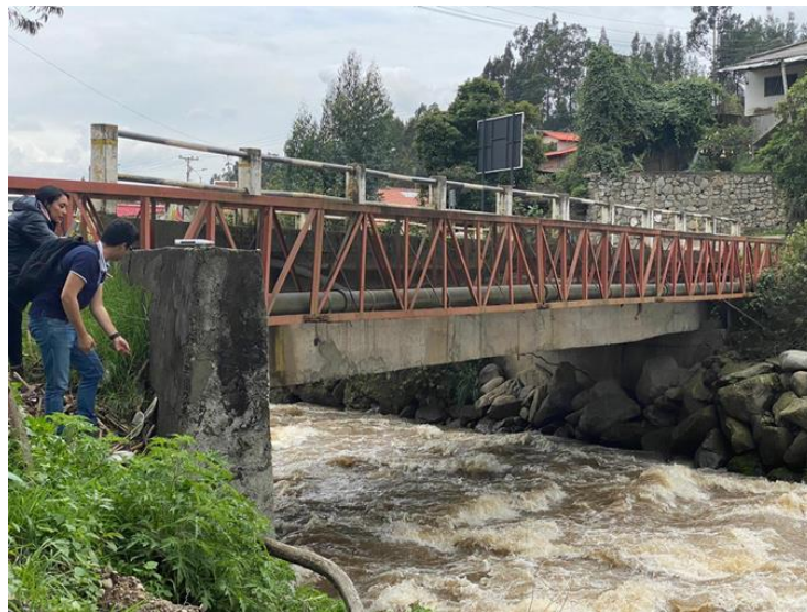
Figura 0.5: Estado actual del puente sobre el río Machángara
