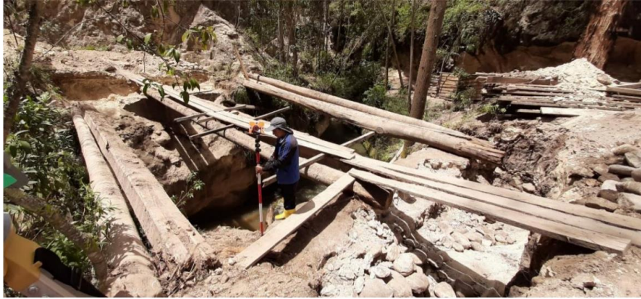
Figura 0.5: Estado actual del puente sobre el río Charqui
