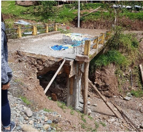
Figura 0.5: Estado actual del puente sobre la quebrada Niuzhuncay
