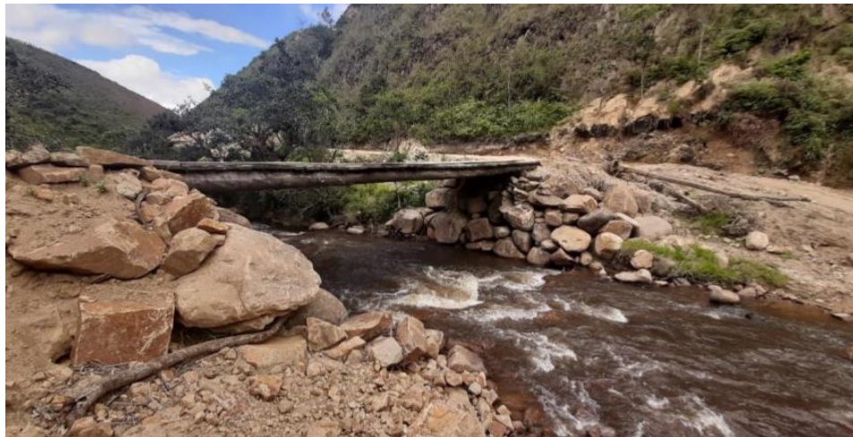
Figura 11.6 Estado actual del puente sobre el río Burro
