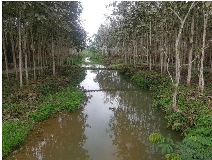
Figura 0.5: Estado actual del puente sobre el río Cañas
