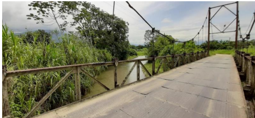
Figura 10.5: Estado actual del puente sobre el río Blanco
