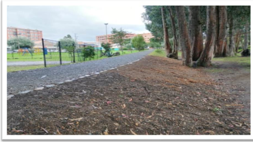
FIGURA 3. 4 RELLENO SOBRE CAMINERA FUENTE: AUTOR
