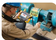
Mantenimiento de Maquinaria
