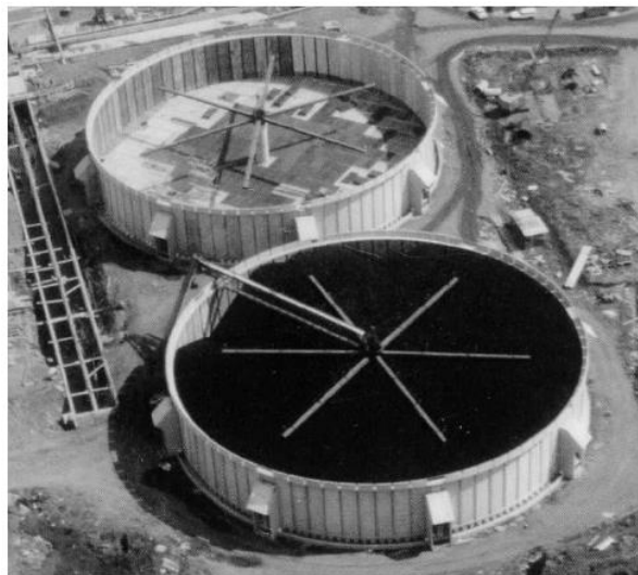
Figura 1 - 2 EDAR de filtro percoladores en construcción.
