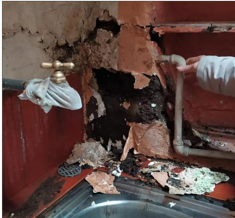
Figura 2.4 Red de tuberías existentes - termino su vida útil
