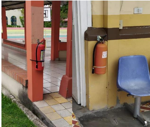
Figura 2.6 Extintores existentes - terminaron su vida útil
