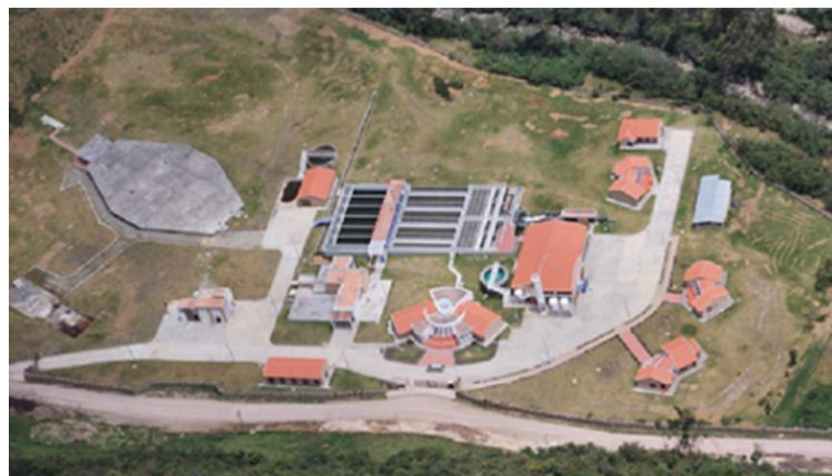
Figura 2.6 Planta de tratamiento Sustag.
