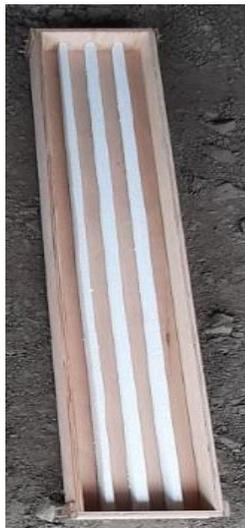
Figura 3.38 Encofrado de losa unidireccional cuatro nervios
