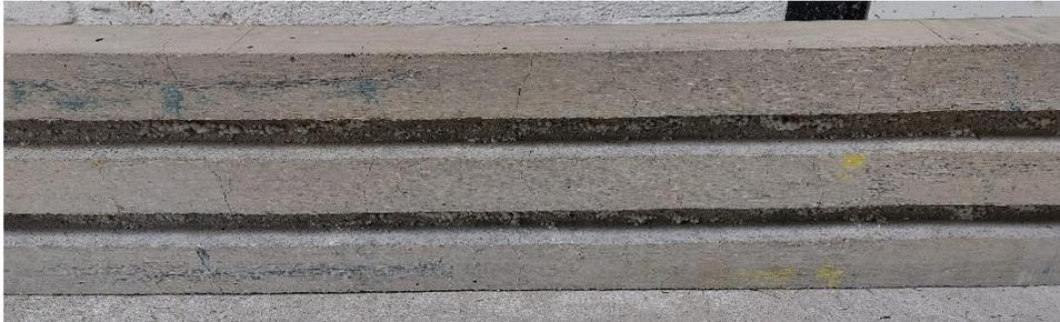
Figura 4.21 Fisuras de losa unidireccional de tres nervios parte inferior
