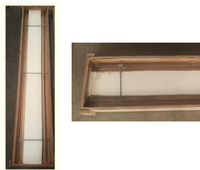
Figura 3.39 Armado de hierros losa unidireccional dos nervios
