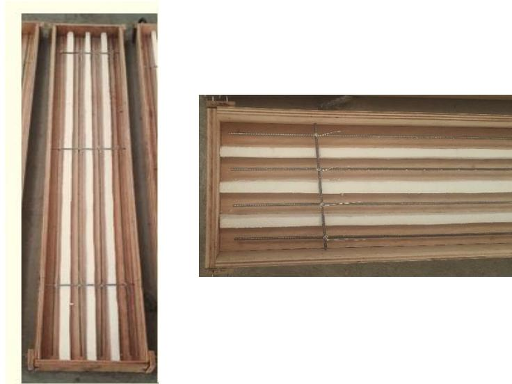
Figura 3.41 Armado de hierros losa unidireccional cuatro nervios
