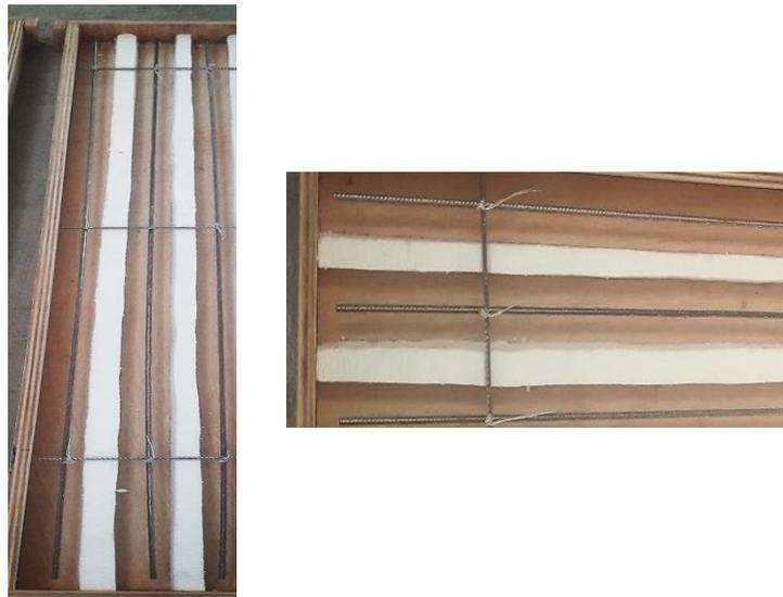
Figura 3.40 Armado de hierros losa unidireccional tres nervios
