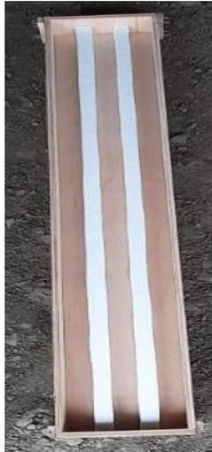
Figura 3.37 Encofrado de losa unidireccional tres nervios
