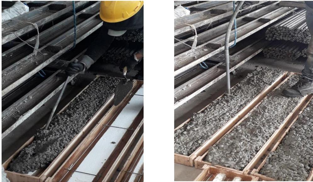
Figura 3.42 Vaciado y vibrado del hormigón en moldes
