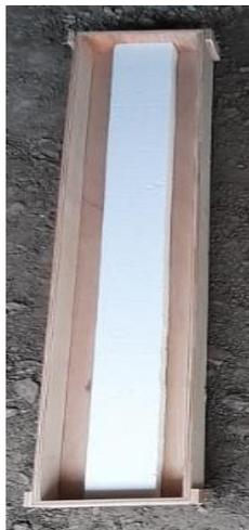
Figura 3.36 Encofrado de losa unidireccional dos nervios
