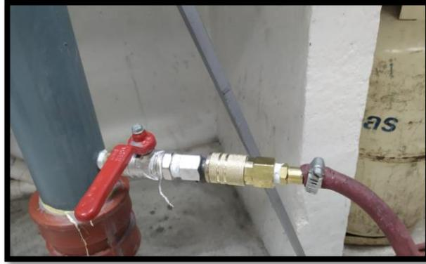
Figura 33: Acople de una llave de paso
