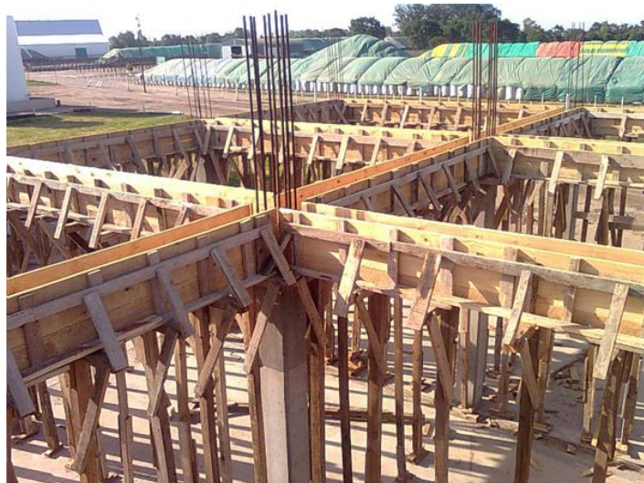
Ilustración 4.2.2: Vigas de hormigón armado
