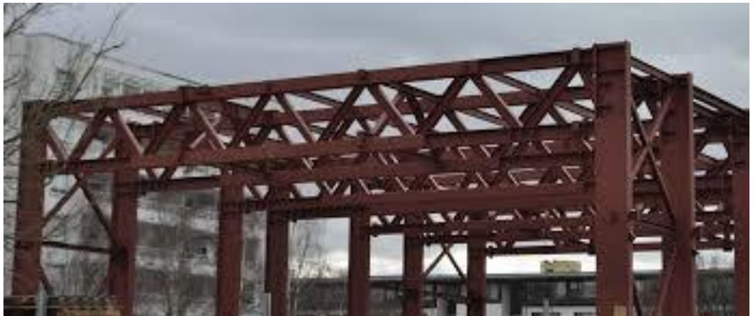
Ilustración 4.4.2: Viga de celosía
