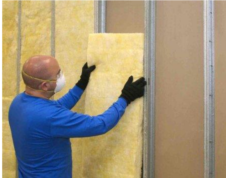
Ilustración 4.2.3.2:31 Colocación de aislante térmico
