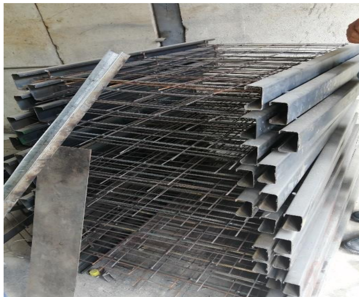
Ilustración 4.3.3.1:32 Refuerzo paneles
