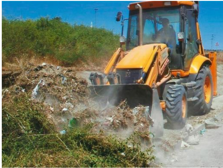
Ilustración 4.1.1.1:28 limpieza y desbroce
