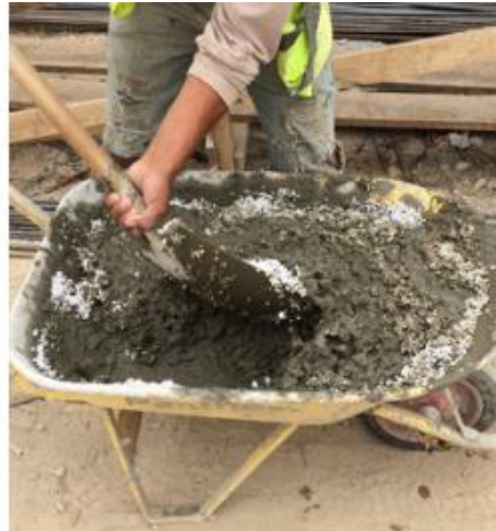
Ilustración 4.3.3.2: Mezcla de hormigón con perlas de poliestireno
