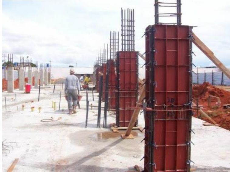
Ilustración 4.2.1:30 Encofrado metálico
