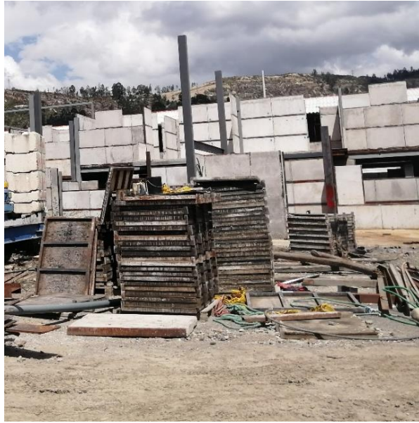
Ilustración 4.4.3: 33 Encofrado metálico
