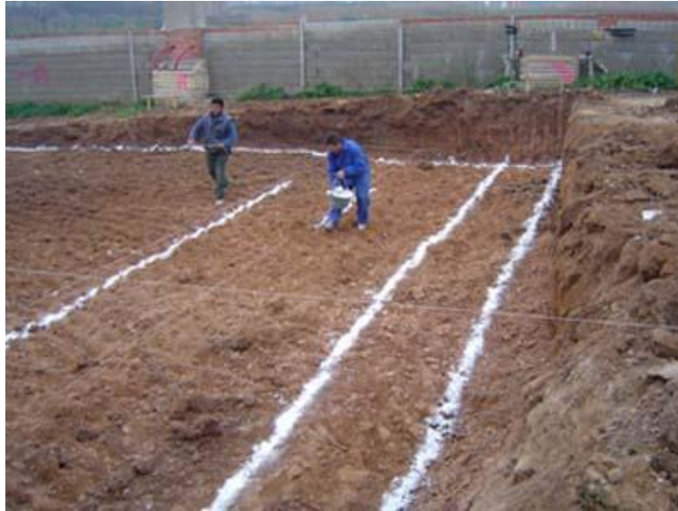
Ilustración 4.1.1.2:29 Replanteo de una obra
