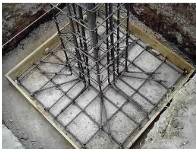
Ilustración 4.1.2: zapatas aisladas
