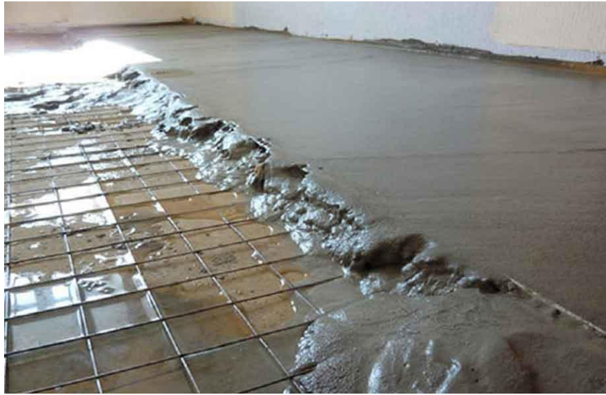
Ilustración 4.1.4: Fundido de piso
