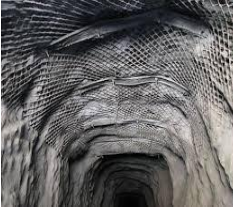
Figura 3.2. Fortificación con mallas de acero reforzadas.
