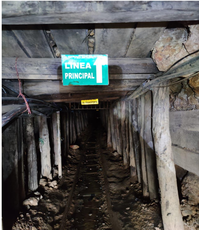
Figura 3.3. Marcos de madera empleados en la bocamina de la concesión “Bomba de Pacchapamba”.
