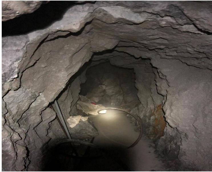
Anexo 15. Tramo del túnel estudiado.
