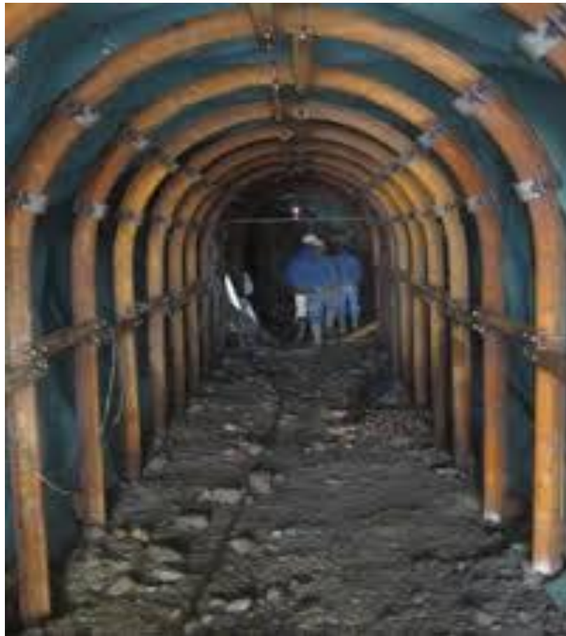
Figura 3.4. Fortificación con marcos metálicos utilizados en Pequeña Minería.
