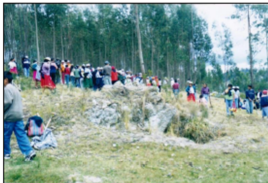
Minga realizada en el sector de Tixán, en el año 2002, construcción del puente que lleva la tubería de 200mm.
