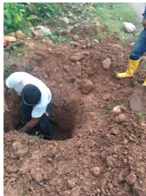
Ilustración 9: Trabajadores realizando el pozo
