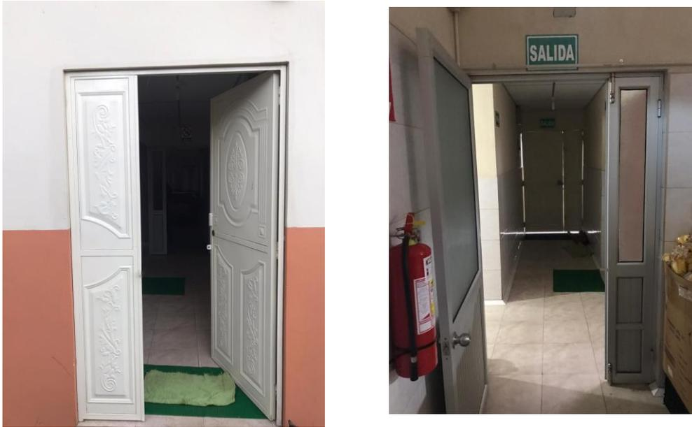
**Figura 23.** Puertas que no se abren hacia afuera.
