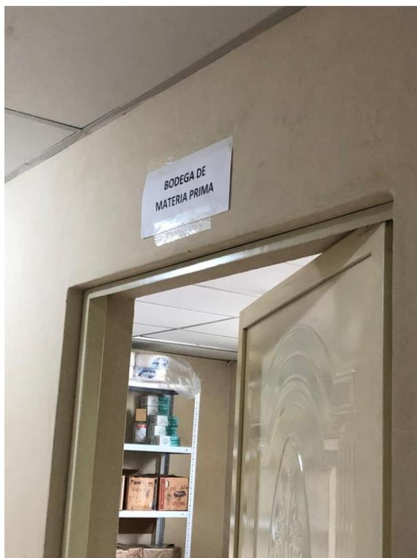
**Figura 34.** Puertas que no se abren hacia afuera.
