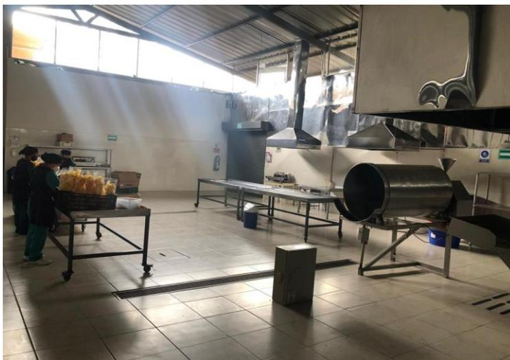
*Figura 27. Suelo de material antideslizante y fácil limpieza.*
