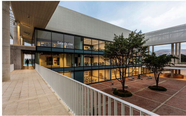
Imagen 21 Vista del patio interior.
