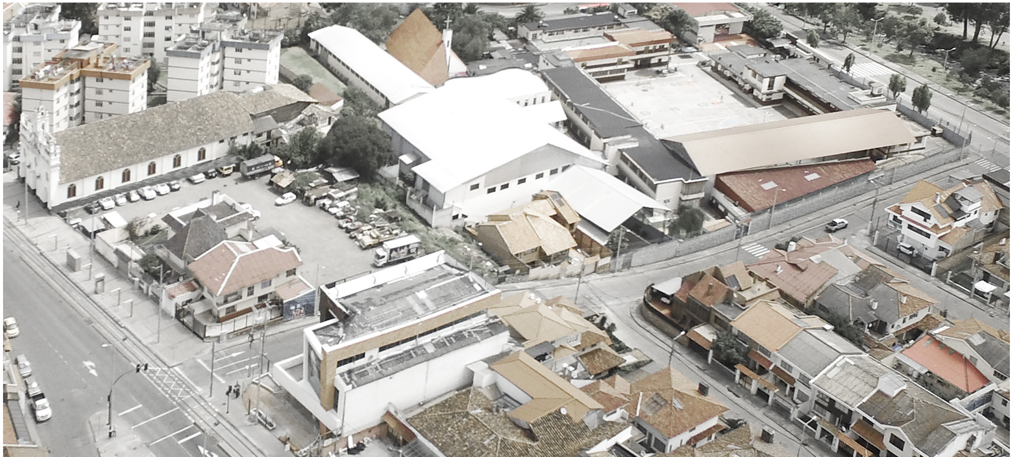
Imagen 72 Estado actual del sitio de oportunidad.
