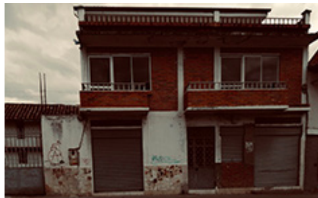
Imagen 38. Visual 3 Vivienda junto al acceso.
