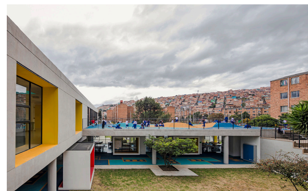
Imagen 27 Vista del patio interior y terraza lúdica.
