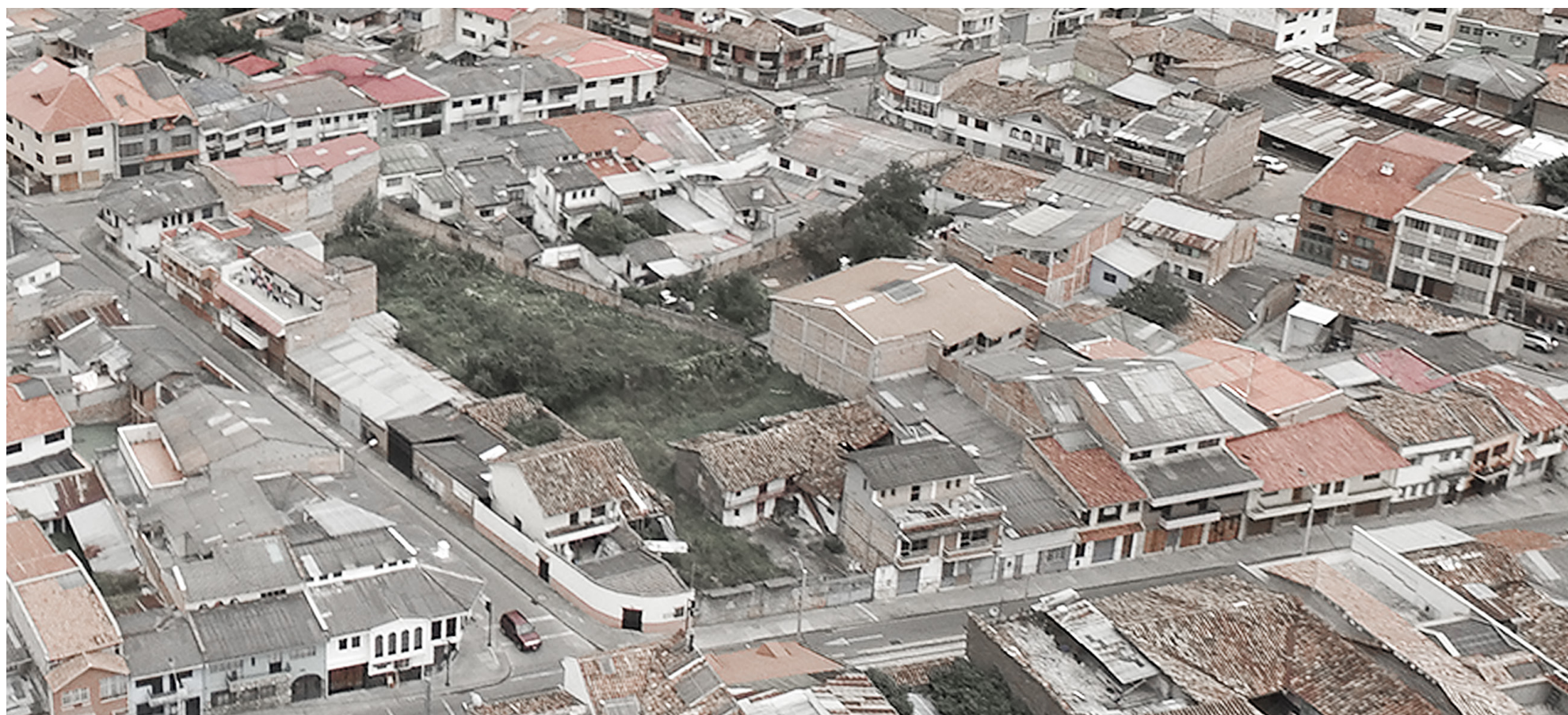
Imagen 63 Estado actual del sitio de oportunidad.
