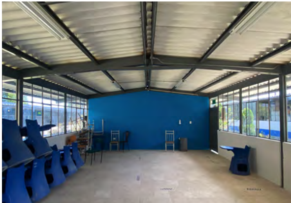
IMG 060: Interior Aula - Fuente Propia
