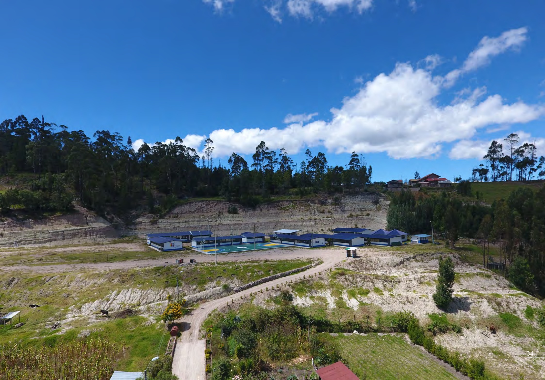
IMG 012: Vista Aérea Terraza Superior - Fuente Propia.
