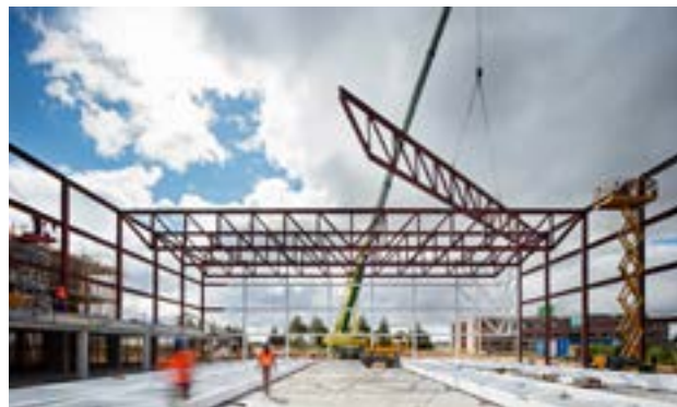
IMG 15 Armado caja de luz de 60x50x12 m. Fuente: https://www.plataformaarquitectura.cl/cl
