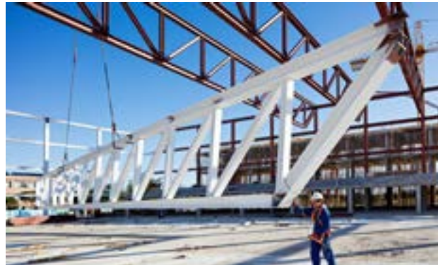
IMG 14 Estructura de acero, Pabellón Fuente: https://www.plataformaarquitectura.cl/cl
