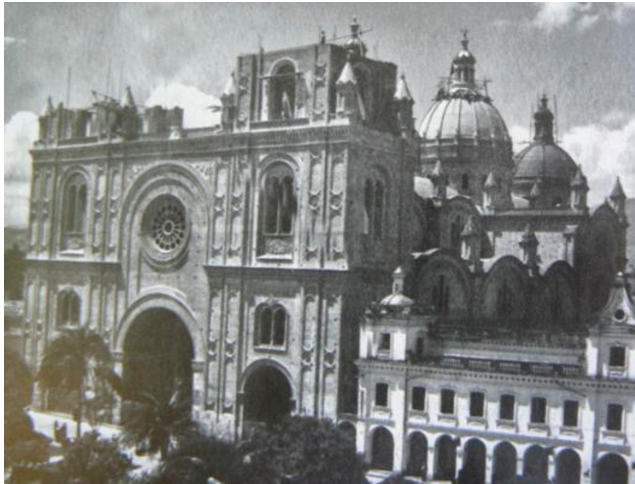
Figura 107: Fotografía de la Catedral de la Inmaculada Concepción en construcción en el año 1953. Fuente: Bravo y Molina.
