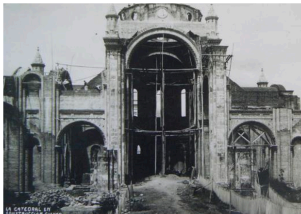
Figura 109: Catedral de la Inmaculada Concepción en construcción. Fuente: Bravo y Molina.
