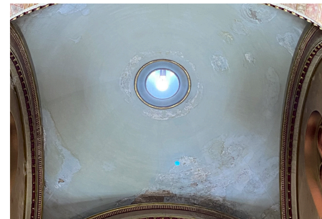
Figura 105: Daños en el cielo raso de la Catedral de la Inmaculada Concepción. Fuente: Elaboración propia.
