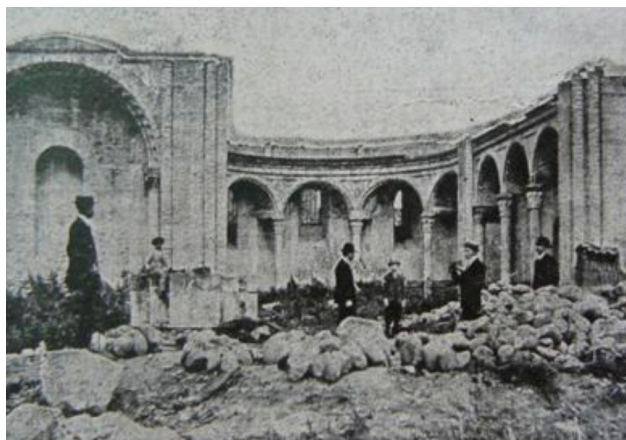
Figura 108: Catedral de la Inmaculada Concepción en construcción, año 1909. Fuente: Bravo y Molina.
