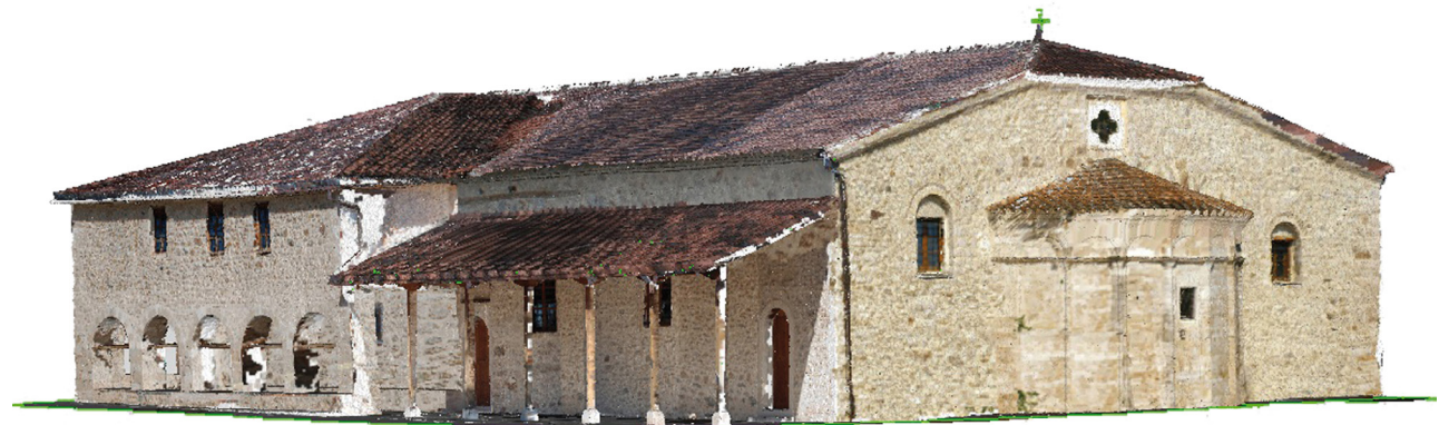
Figura 40: Nube de puntos obtenida con escaneo láser. Fuente: Ioannakis Georgios-Alexis y Sidiropoulos Andreas.
