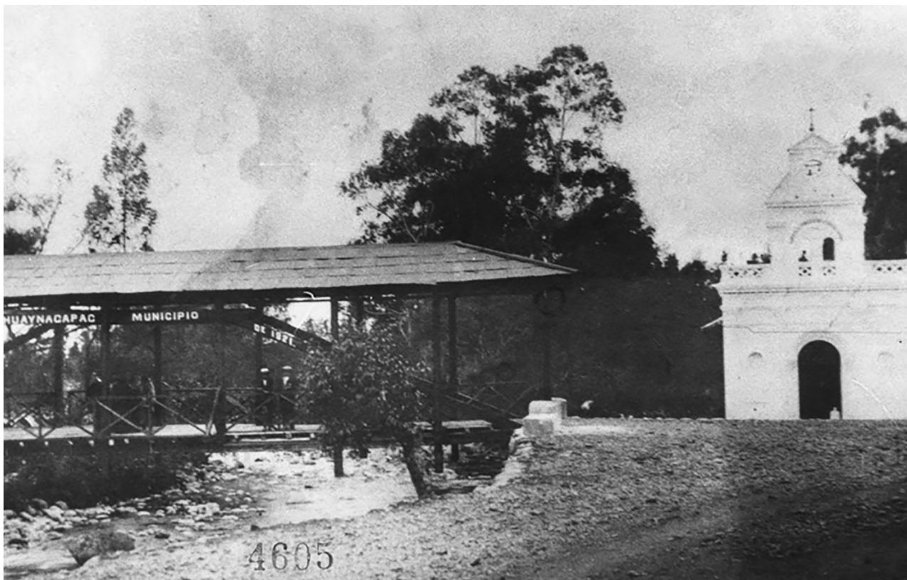
Img. 10 Antiguo Puente de "El Vergel", con la iglesia destruida por
