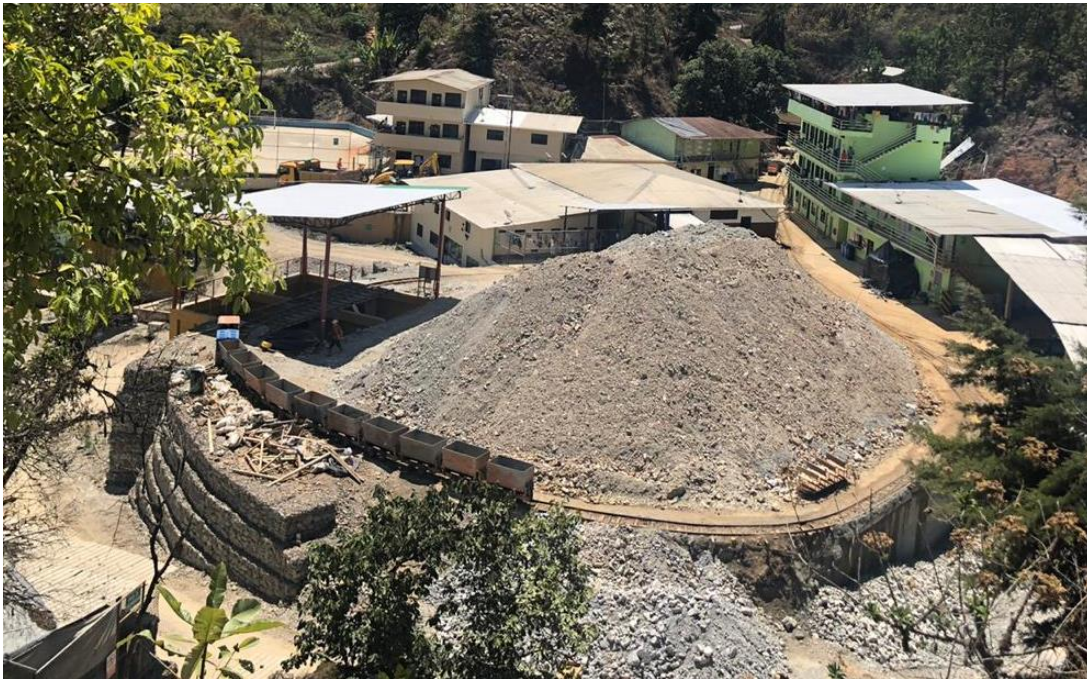
Figura 1.3 Campamento minero Grumintor
