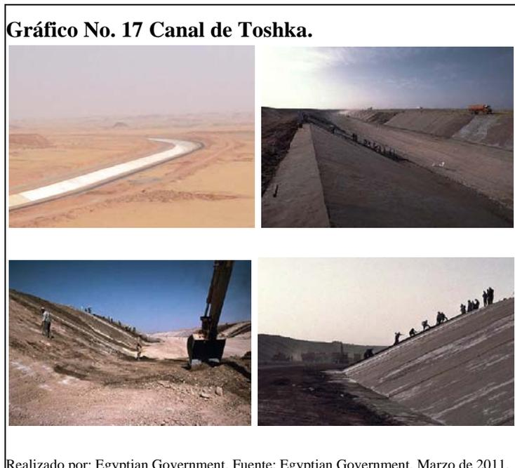
Se pretende evitar las pérdidas de agua por filtración construyendo un revestimiento de cemento, arena, hormigón y polímero en todo su trayecto, se dice que para conseguir irrigar el canal, fue necesaria una enorme estación de bombeo (la mayor del mundo) en Toshka, recién inaugurada en el año 2005. La estación, bombea unos 25 millones de metros cúbicos. En suma, se pretende habilitar unas 588.000 hectáreas de desierto como
