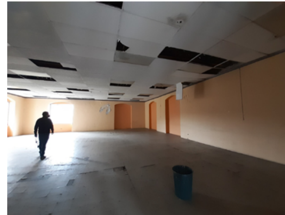
Estado actual de las galerías
