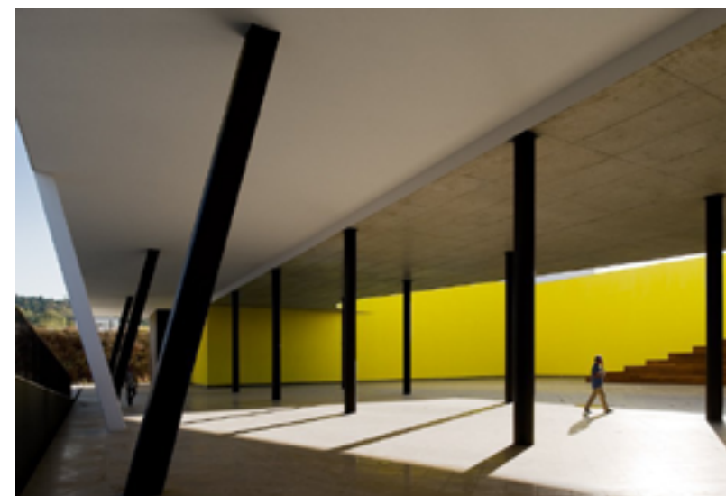
Imagen 27: Patio Interior. Autor: FS+SG (s.f)
