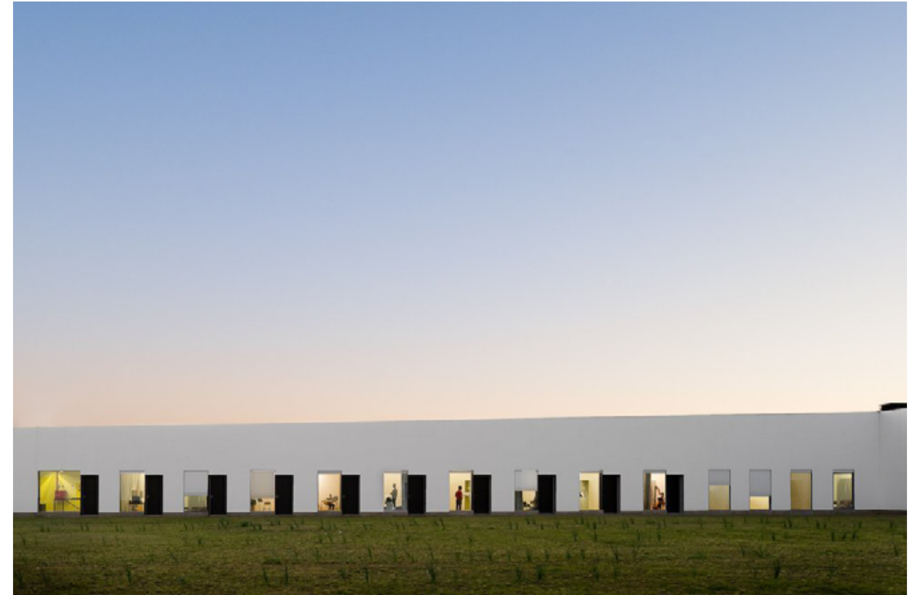
Imagen 21: Fachada Autor: FS+SG (s.f)
