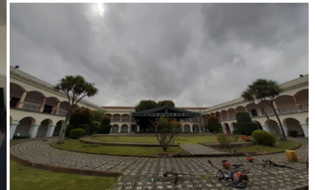
Estado actual del patio
