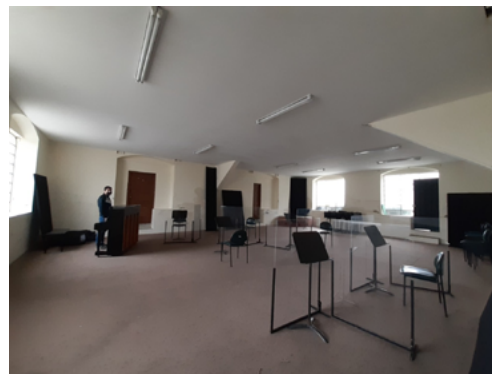
Sala de ensayo grupal estado actual
