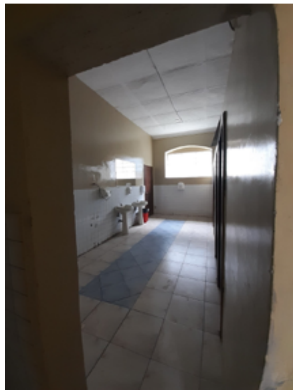
Estado actual de los baños
