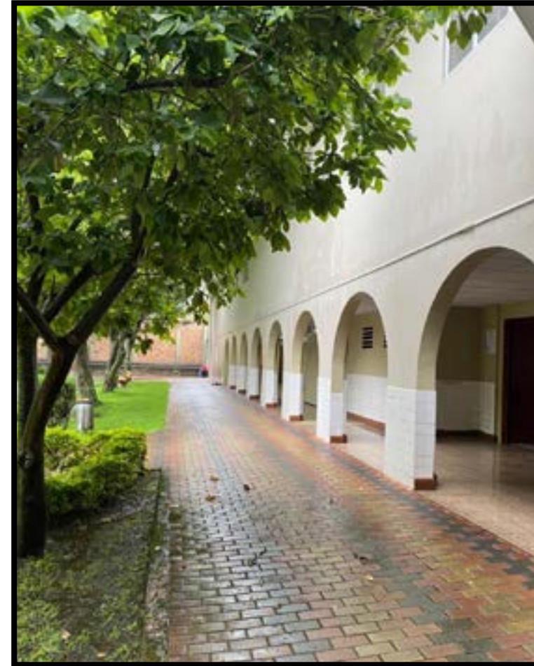
Imagen 39: Pasillo mujeres, estado actual
