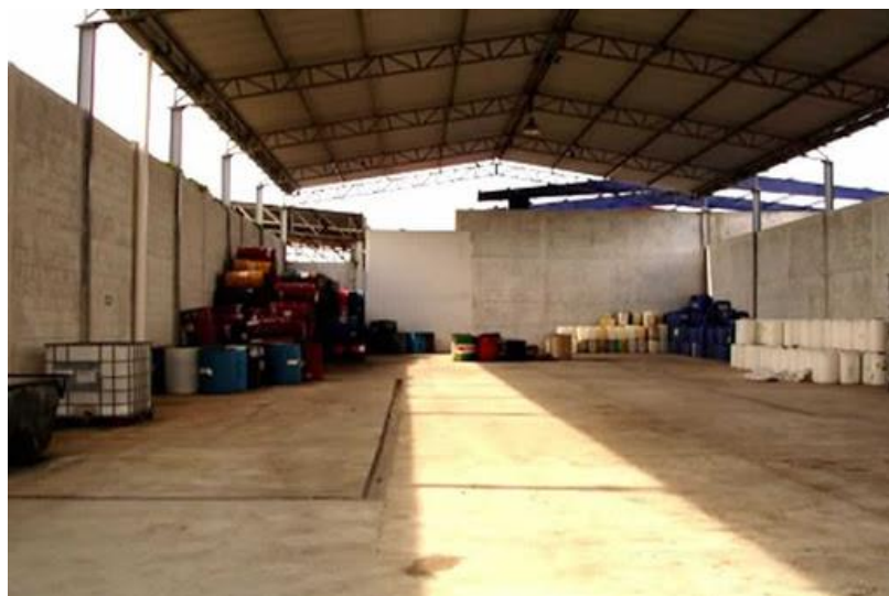
Figura 8 Sitio de acopio
