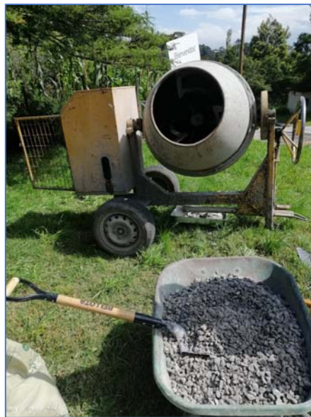
Figura 3.14 Colocación de materiales en la concretera
