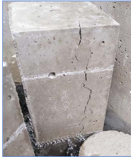
Figura 4.16 Presencia de grietas en viguetas con refuerzo de bambú (tablillas)
