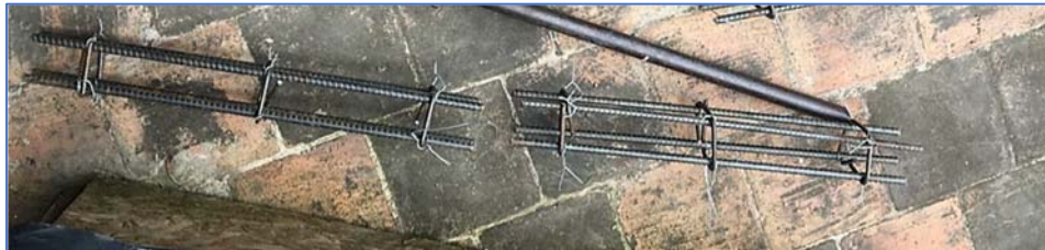
Figura 3.2 Armadura de acero de refuerzo
