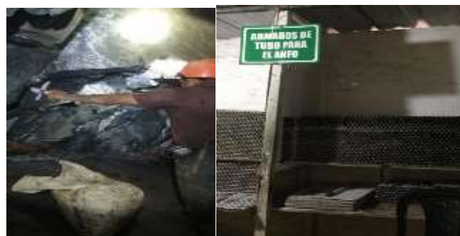
Figura 4.2 Evidencia riesgo mecánico.
