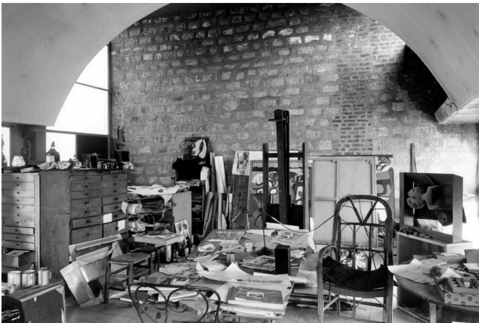
Ilustración 12. Apartamento atelier en el edificio "24 NC", Le Corbusier Paris, 1934.
