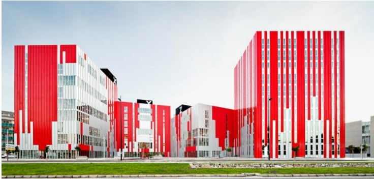
Ilustración 33. Edificio VIVIENDA UNIVERSITARIA de los Arquitectos Guallart, en España 2007.
