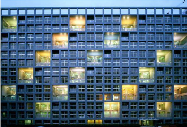
Ilustración 29. Edificio residencial multifamiliar Shinonome Canal Court Arq. Yamamoto (Tokio)
