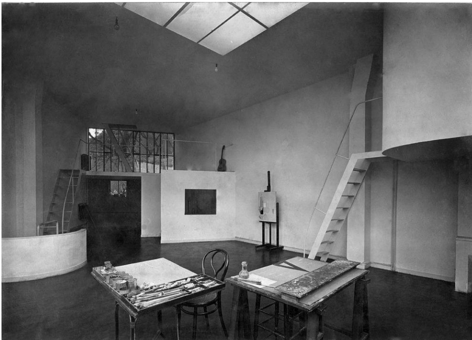
Ilustración 11. Apartamento atelier en el edificio "24 NC", Le Corbusier Paris, 1934
