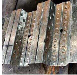
Figura 4.16. Perforación en la placa colaborante
