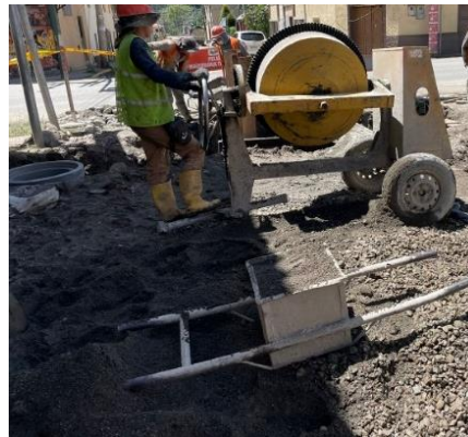
Figura 4.22. Mezcla de hormigón mediante el uso de la concreteira
