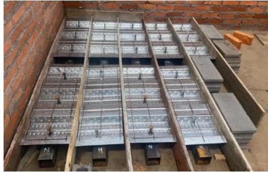
Figura 4.19. Colocación del encofrado
