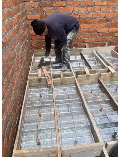
Figura 4.23. Fundición de losas
