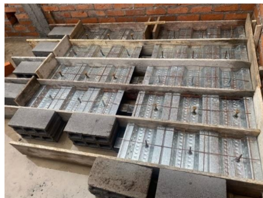
Figura 4.20. Finalización del encofrado
