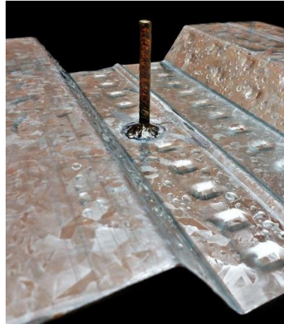
Figura 2.11. Conector de corte tipo varilla
