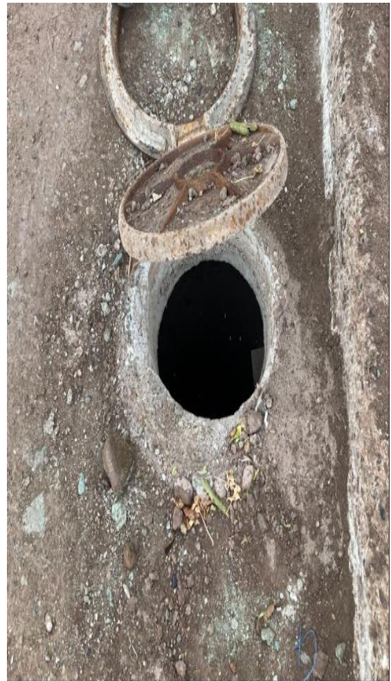
Figura 2.5: Estado del pozo revisión.
