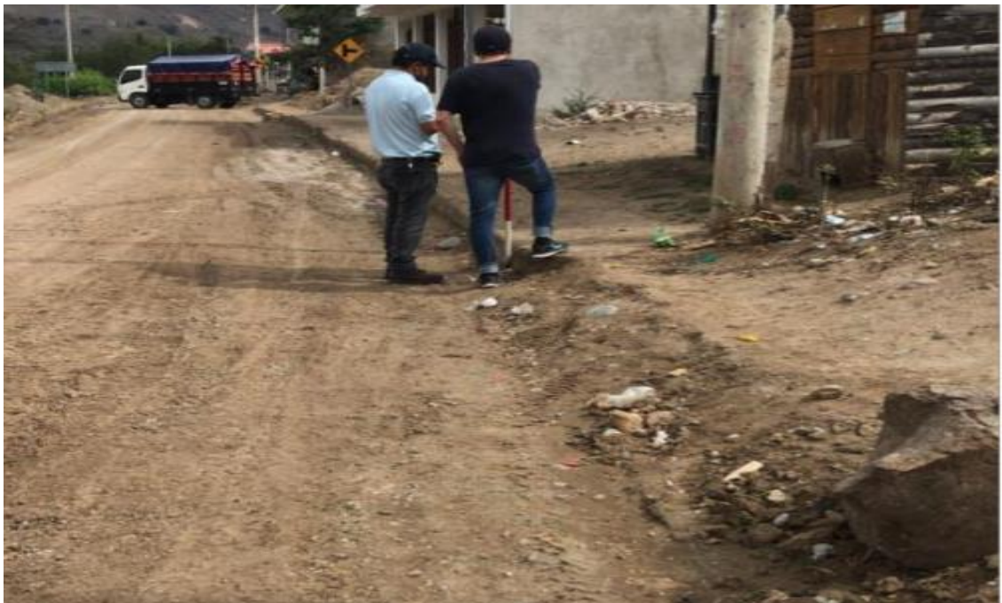
Figura 2.7: Estado de la vía principal de Uchucay.
