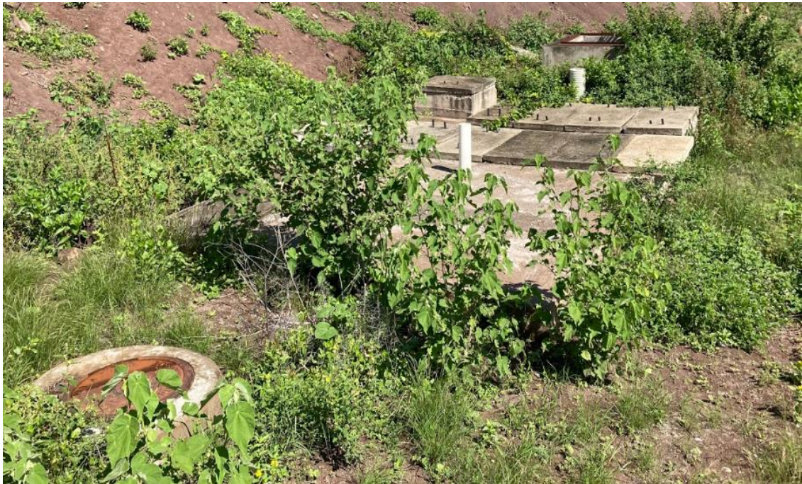
Figura 3.9: Estructuras existentes del PTAR del barrio Uchucay.
