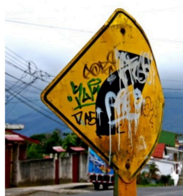
Figura 1. Denuncie las señales de tránsito en mal estado.
