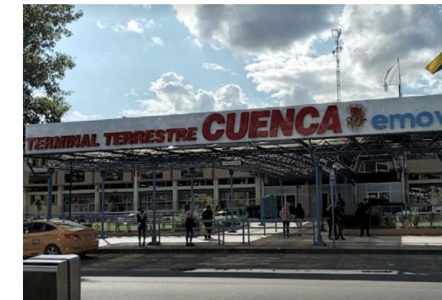
Fig. 27. Terminal Terrestre entrada. Fuente: Marco Tenemaza
