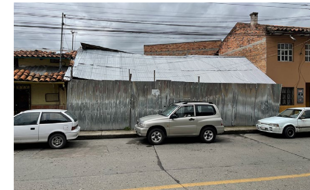
Fig. 87. Vivienda Temporal. Fuente: Foto propia
