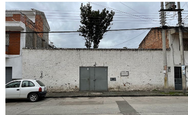
Fig. 78. V2 - Centro de salud. Fuente: Foto propia.
