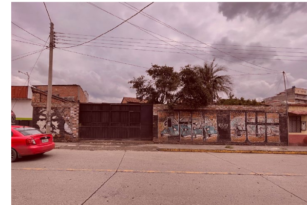
Fig. 4. Muros ciegos. Fuente: Foto propia
