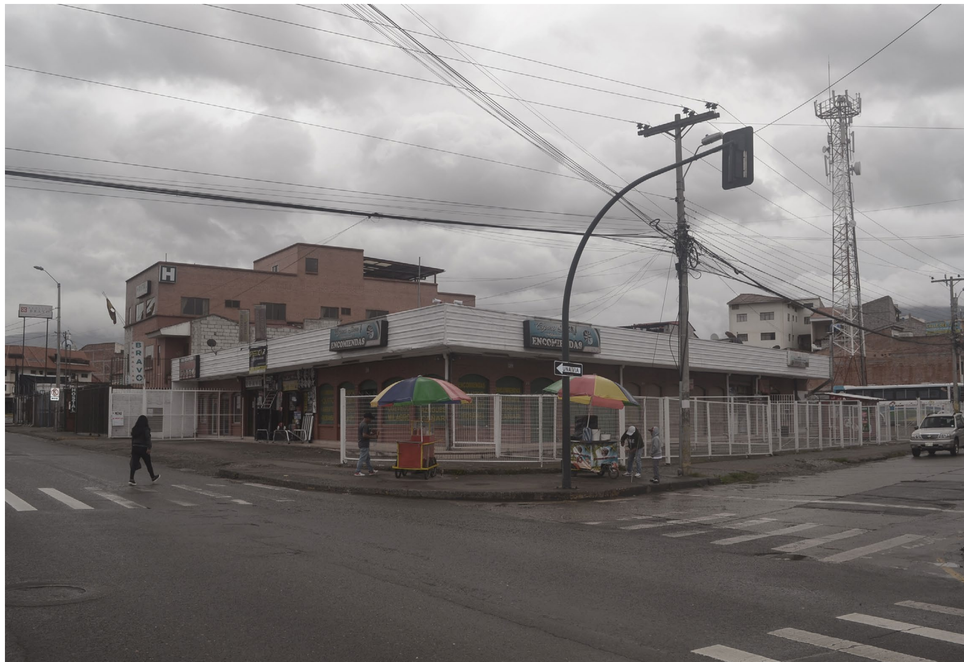
Fig. 89. Av. Gil Ramírez Dávalos. Estado actual. Fuente: Foto propia.
