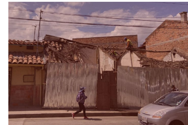
Fig. 5. Predios en mal estado. Fuente: Ana Calle / El Mercurio
