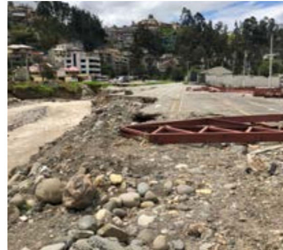
Fig. 43. Estructura removida. Fuente: elaboración propia.
