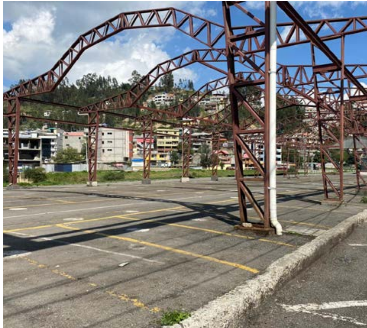
Fig. 38. Infraestructura. Fuente: elaboración propia.
