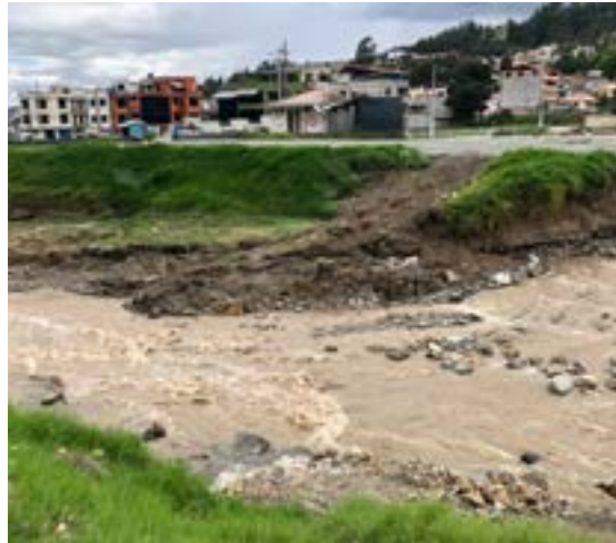
Fig. 40. Suelos erosionados. Fuente: elaboración propia.
