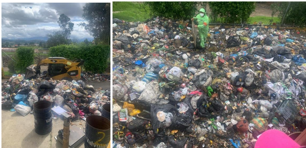
Figura 29 Mini cargadora esparce los residuos para ser separados en 4 grupos
