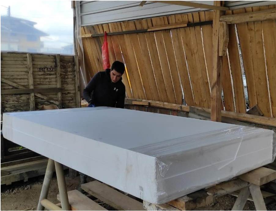
Figura 59. Planchas de poliestireno expandido EPS de alta densidad 15 Kg/m 3 .
