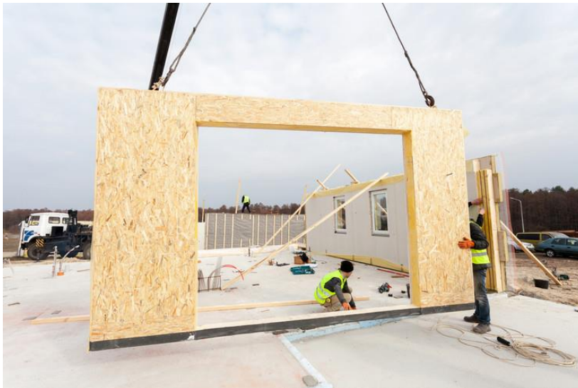
Figura 1 Construcción modular de una vivienda
