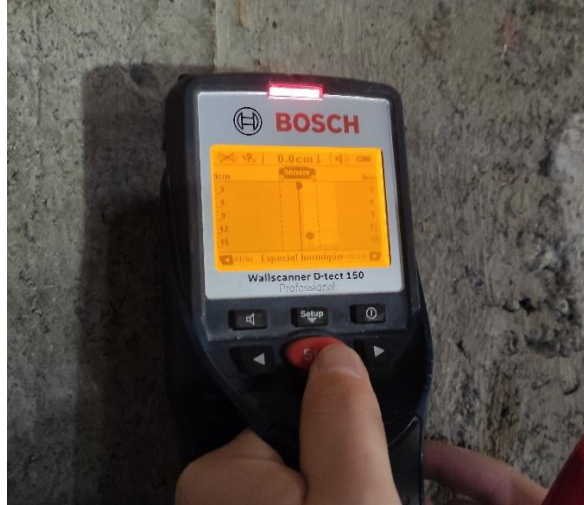
Figura 2.8. Toma de datos mediante escáner de armados Fuente: Propia (2022)
