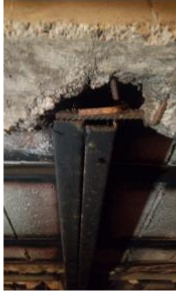
Figura 2.21. Viguetas soldadas a armadura de vigas de hormigón Fuente: Propia (2022)
