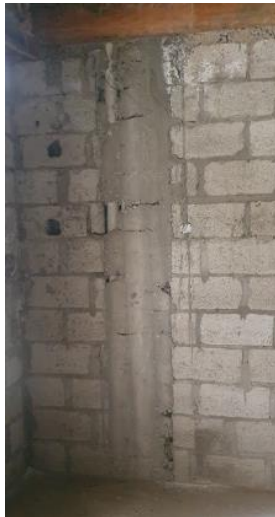
Figura 2.15. Desprendimiento y segregación de hormigón en columnas Fuente: Propia (2022)
