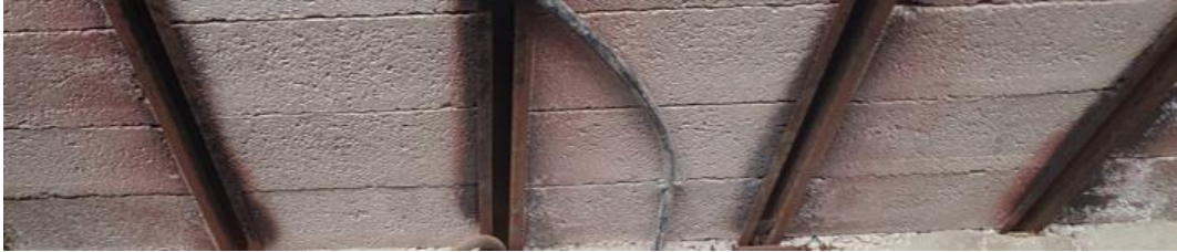
Figura 2.23. Perfiles omegas oxidados Fuente: Propia (2022)
