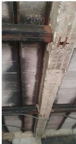
Figura 2.20. Vigas interrumpidas por vigas de metal Fuente: Propia (2022)
