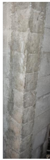
Figura 2.15. Desprendimiento y segregación de hormigón en columnas Fuente: Propia (2022)
