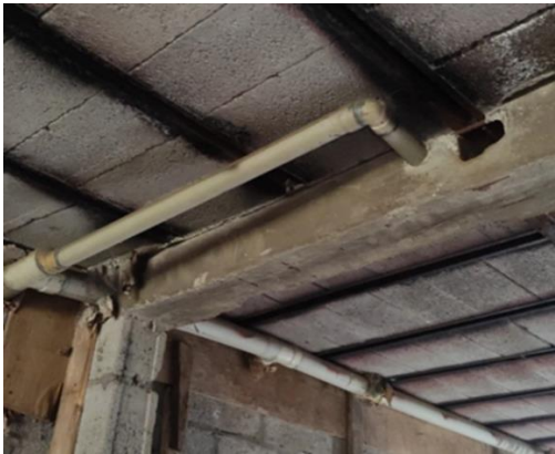
Figura 2.22. Vigas atravesadas por tuberías Fuente: Propia (2022)
