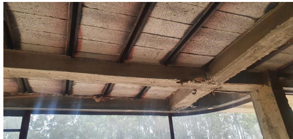
Figura 2.30. Unión en cruce de vigas de hormigón
