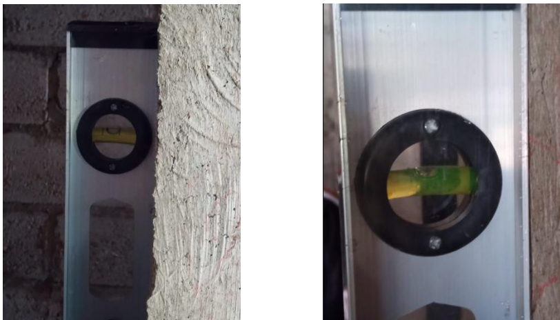
Figura 2.17. Nivelación de columnas Fuente: Propia (2022)
