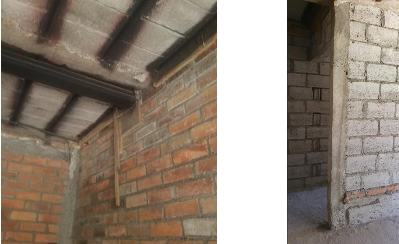
Figura 2.16. Columna apeada que nace del entrepiso Fuente: Propia (2022)
