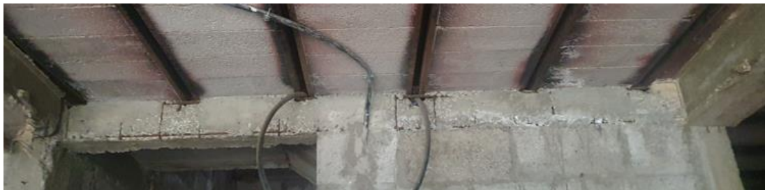
Figura 2.18. Desgaste del recubrimiento Fuente: Propia (2022)
