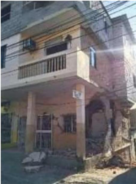
Ilustración 1 casa con eje vertical discontinuo. Fuente: NEC-2015.
