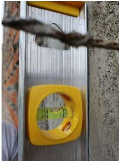
*Ilustración 2.3.1 revisión de inclinación de la columna.
