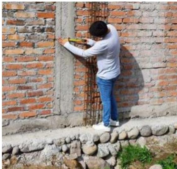
*Ilustración 1.1.1.1: Medición aproximada del grosor de las columnas.*
