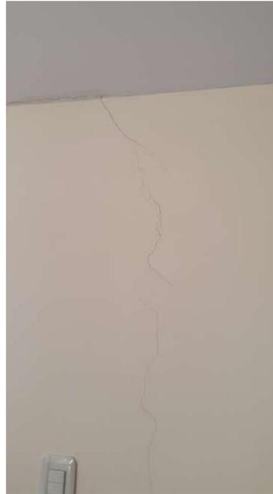
*Ilustración 12 Agrietamiento en el empalme pared – losa.
