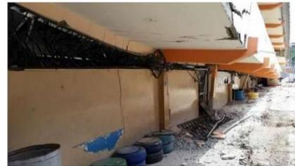
Ilustración 4 Columnas de menor resistencia que las vigas. Fuente: NEC-2015.
