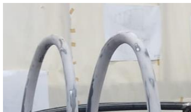
Figura 12 Refuerzos en la parte posterior de la zona del piloto
