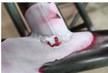
Figura 17 Discontinuidad en el cordón de soldadura
