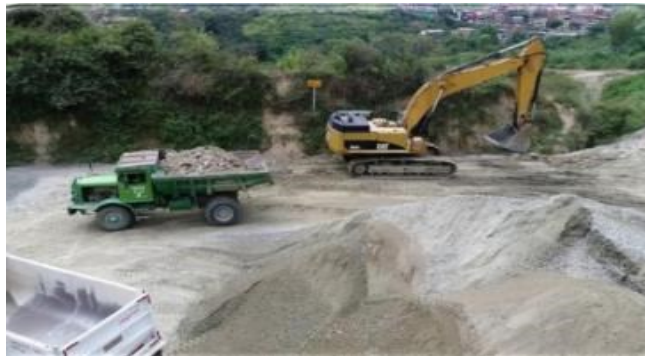
Figura 1.11. Zona de stock y carga
