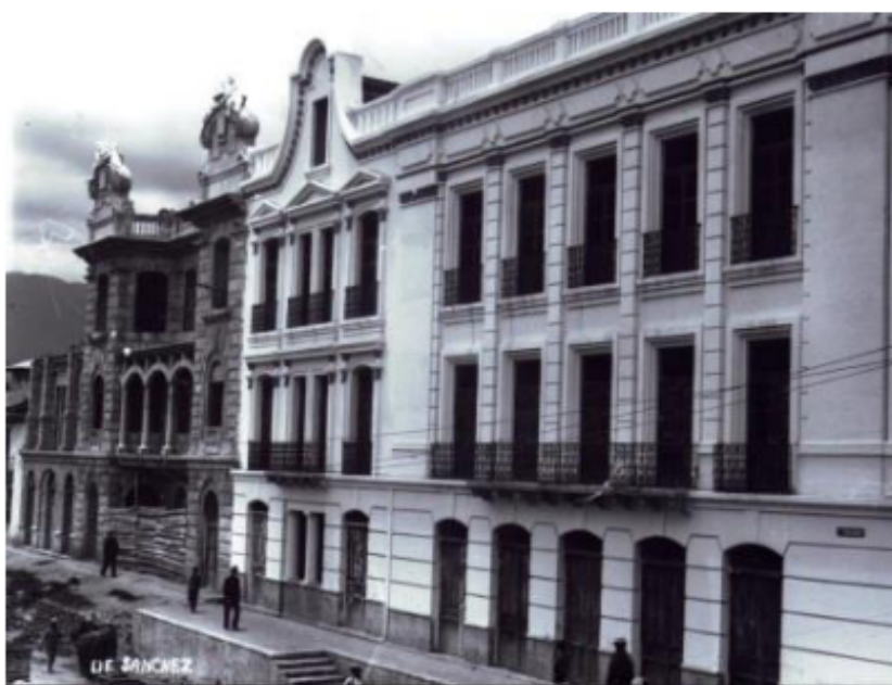
Figura 3.9 Fachada original “Casa Condamine” años 30. Fuente: J.S. Sánchez. Archivo personal Arq. G. Lloret O. Fotos antiguas Cuenca
