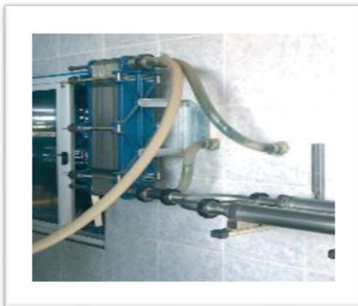
Figura 10. Intercambiador de calor de placas para pre-refrigeración de leche. Fuente: (Callejo, 2013).
