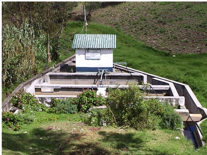
**Figura 7.** Tanque de lixiviados.
