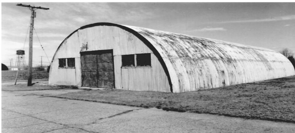
Figura 2.2 Nave industrial de techo curvo
