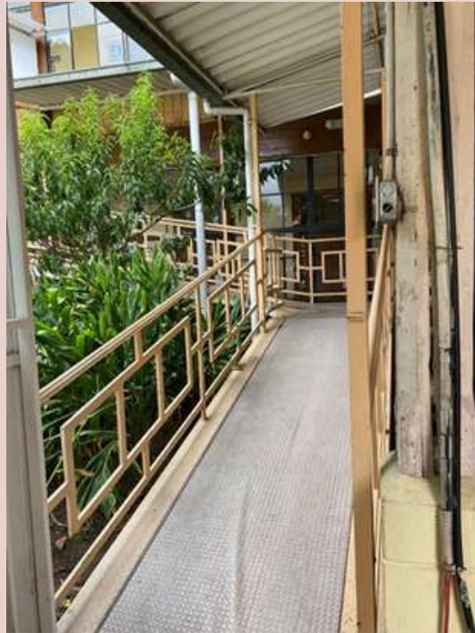
Figura 54: Rampa- Acceso a las alas de terapia Fuente: Autoria Propia
