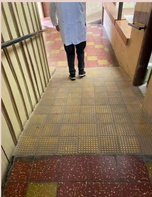
Figura 48: Rampa- Acceso a las alas de terapia Fuente: Autoria Propia
