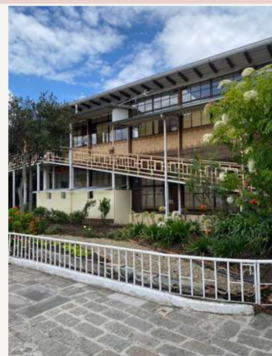
Figura 46: Rampa- Acceso al segundo piso Fuente: Autoria Propia
