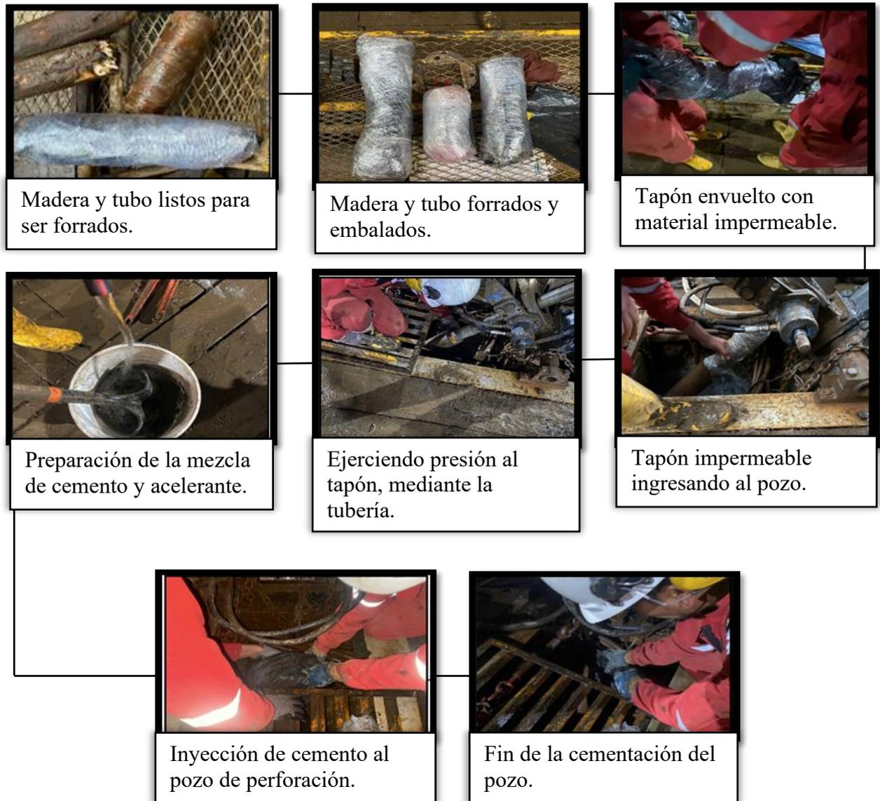
**Figura 2.8** Metodología de obturación de pozo por presencia de acuífero
