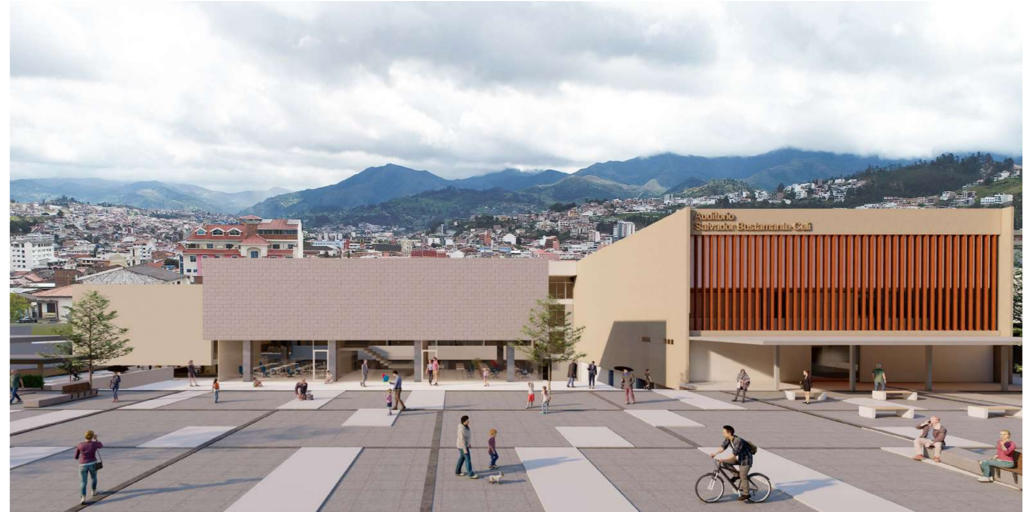
Img.79: Vista desde la plaza externa multiusos
