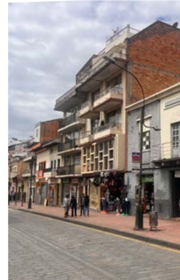
Figura 85. Vista frontal (Elaboración propia)
