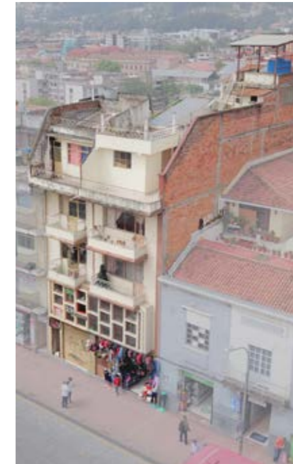
Figura 82. Vista frontal (Elaboración propia)
