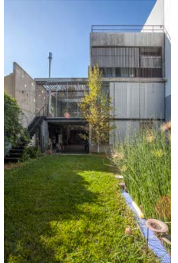
Figura 24. Edificio Grecia 4166, fachada posterior.
