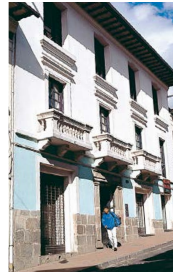
Figura 36. Fachada frontal después de la remodelación. Junta de Andalucía, 2019.
