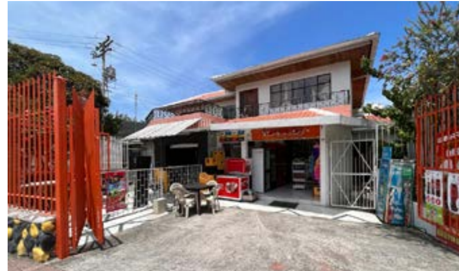
Terreno de oportunidad adosado al terreno seleccionado
