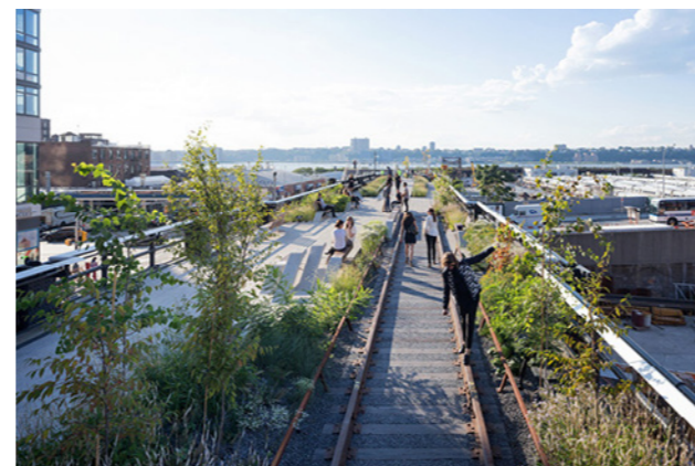
Figura 33. Restauración de los rieles. Fuente: Iwan Baan, 2009.
