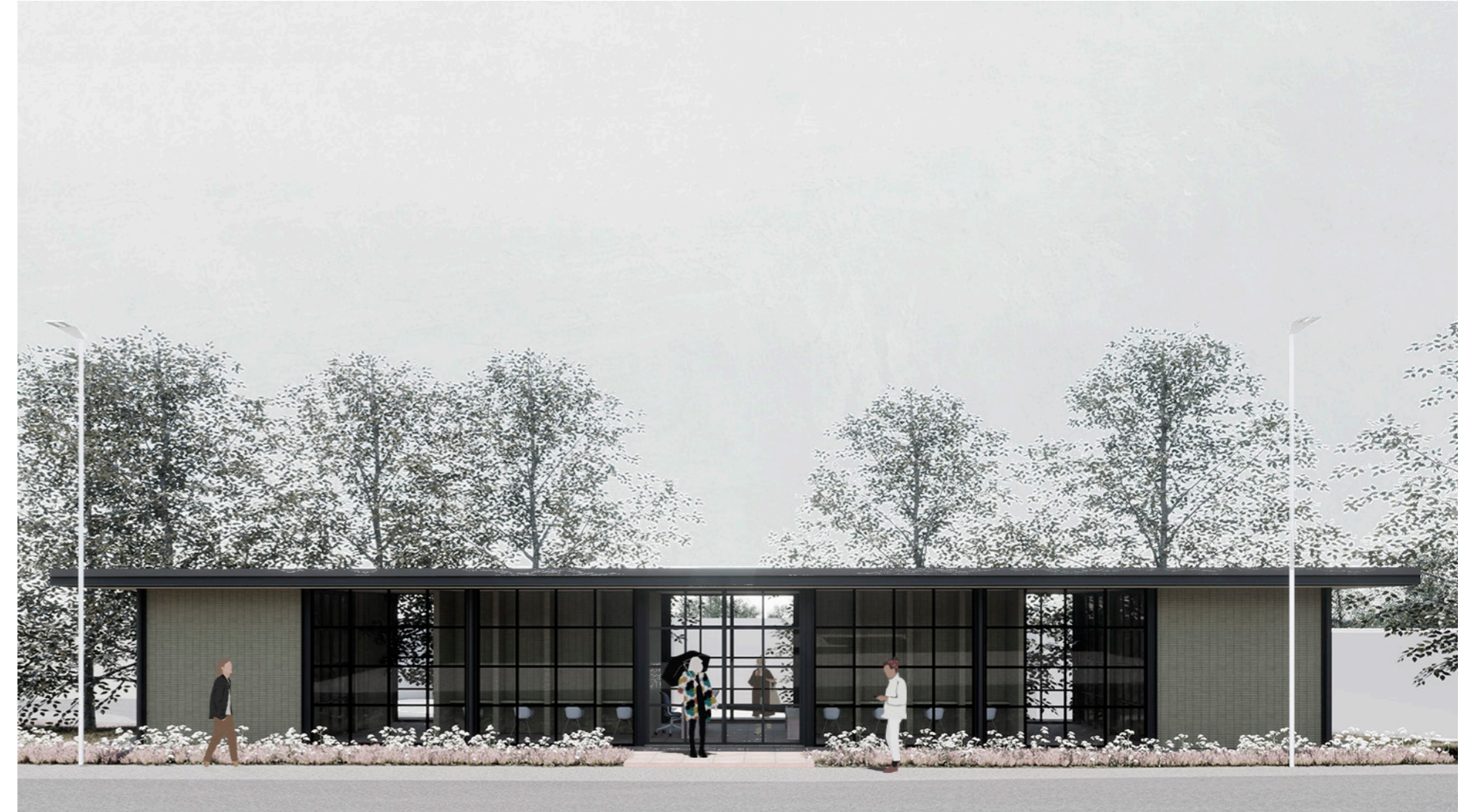
Figura 71. Vista desde la calle Joan Tenecela bloque coworking.
