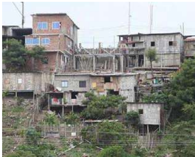
IMG 95. Asentamientos insormales en las riberas del río, junto al parque industrial (2022). Jean Carlos Saavedra Palacios
