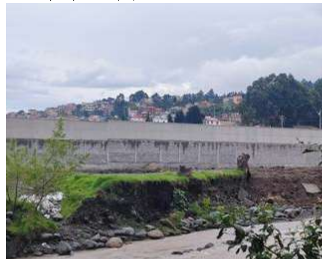
IMG 60. Fachas Camal Municipal (2023). Fuente: propia.
